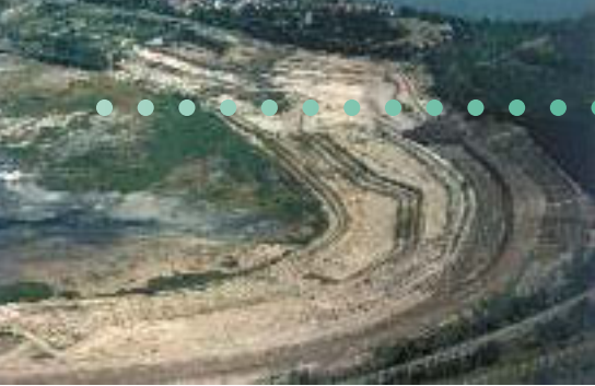
In Sanierung befindlicher West- böschungsbereich, 1999
