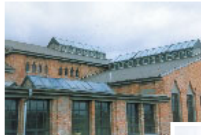
Früher Maschinenhalle der Brikettfabrik Braunsbedra - jetzt entsteht ein Zentrum für Zukunftstechnologie, Kunst und Design
