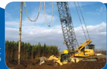
Rütteldruckverdichtung am Altdöberner See, 2008
