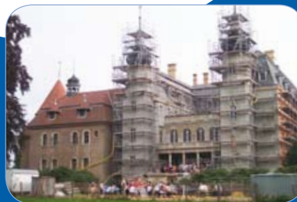
Tag des Offenen Denkmals 2005 während der Fassadensanierungsarbeiten
