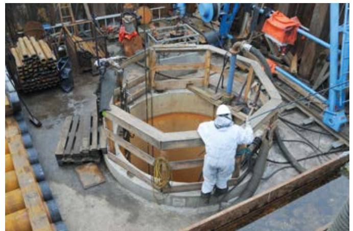
Ein Horizontalfilterbrunnen im Bau
