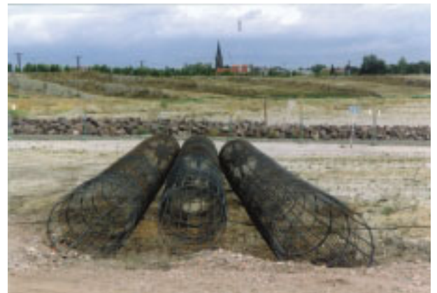
Bewehrung für die 42 Großbohrpfähle
