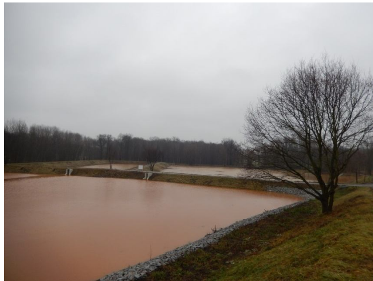
Abb. 4.1.2: Absetzbecken Eichower Fließ
