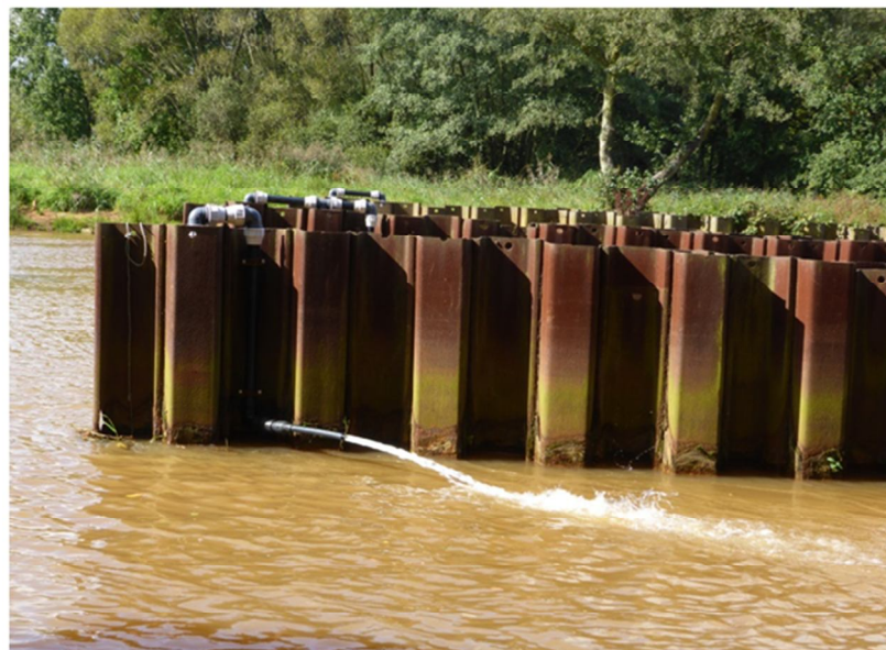
Abb. 4.1.5: Vorsperre Bühlow , Zugabe von Flockungshilfsmittel
