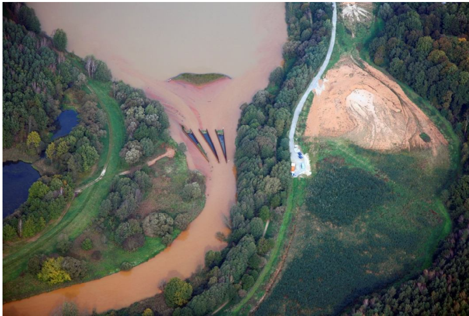
Abb. 4.1.4: Vorsperre Bühlow , Talsperre Spremberg
