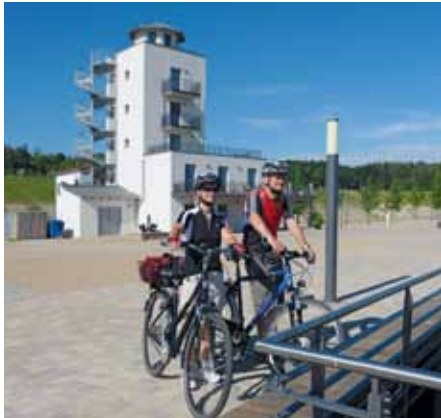
Hafenturm der Marina Muehlen
