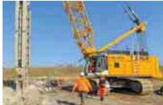
*Bau einer unterirdischen Dichtwand zwischen Markleeberger See und Störnthaler See, 2011*
