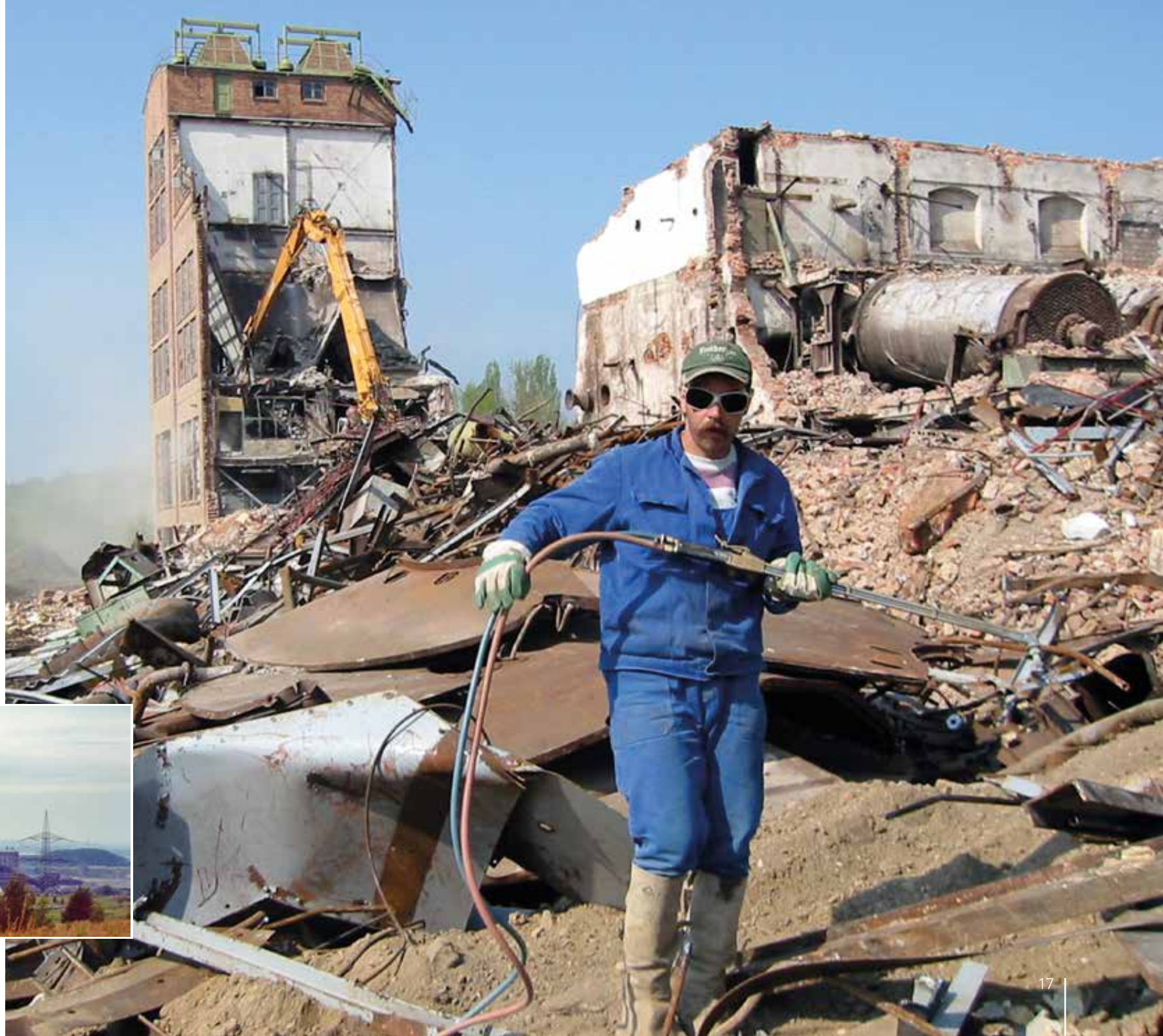
Abriss der Brikettfabrik Zechau, 2004
