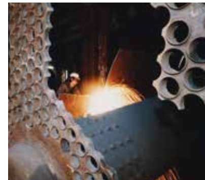
Rückbau der Röhrentrockner in der Brikettfabrik Regis-Breitungen, 1996 Schornsteinsprengung in Espenhain, 1999
