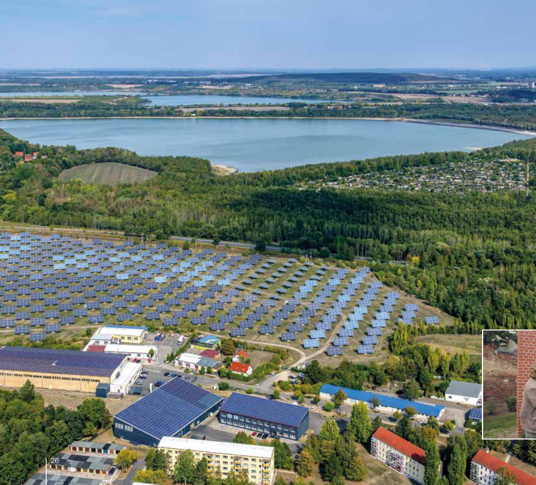
Solkraftwerk Borna (vorn), im Hintergrund der Speicher Witznitz und der Hainer See., 2016
