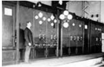
Kraftzentrale des Braunkohlenwerkes Deutzen, um 1910
