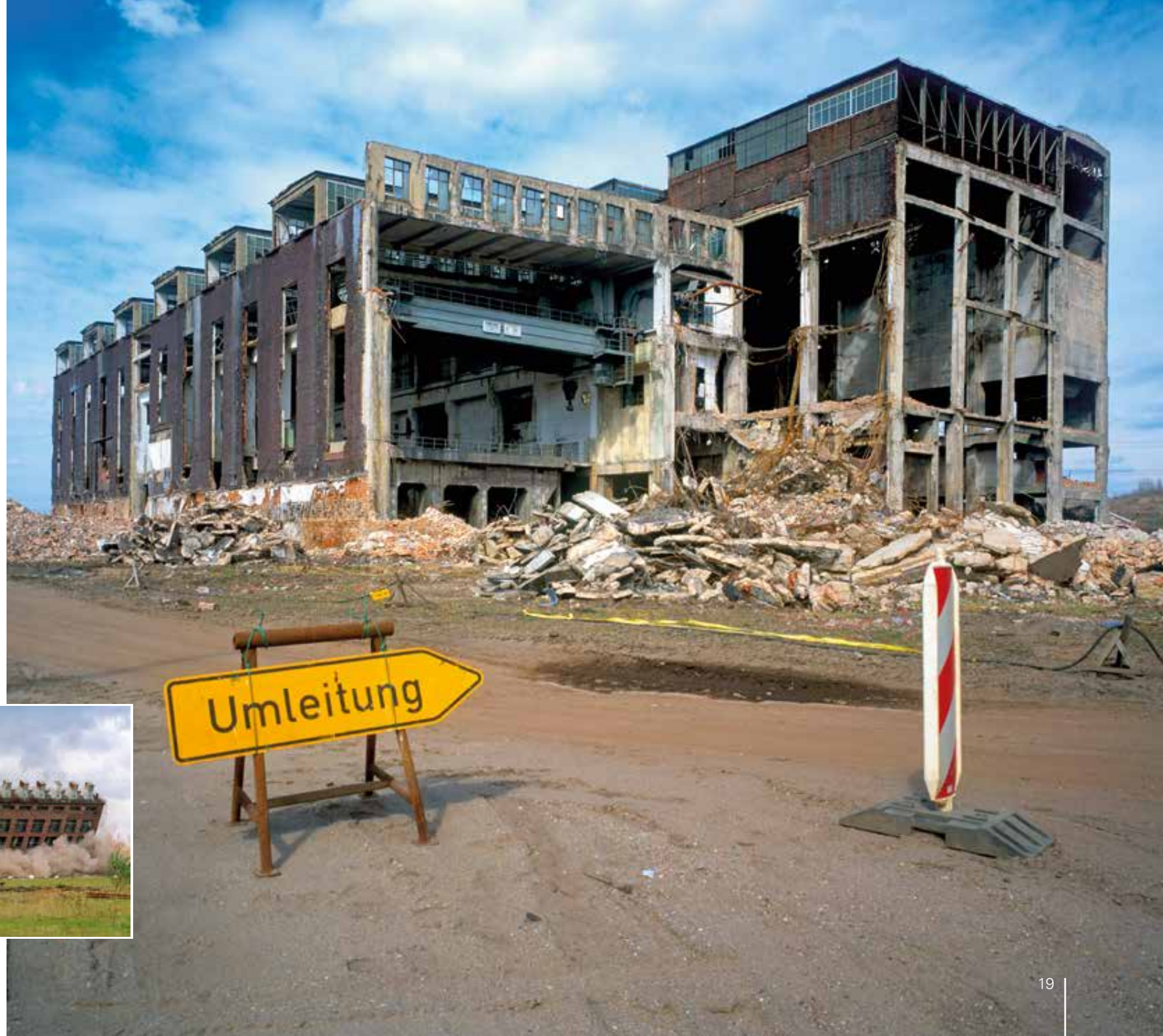
Abbruch des Kraftwerks I am ehemaligen Veredlungsstandort Espenhain, 2003
