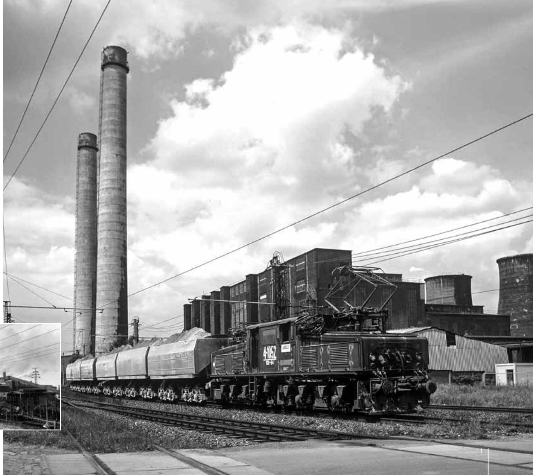
Kraftwerk I Espenhain mit Aschezug, 1996.
