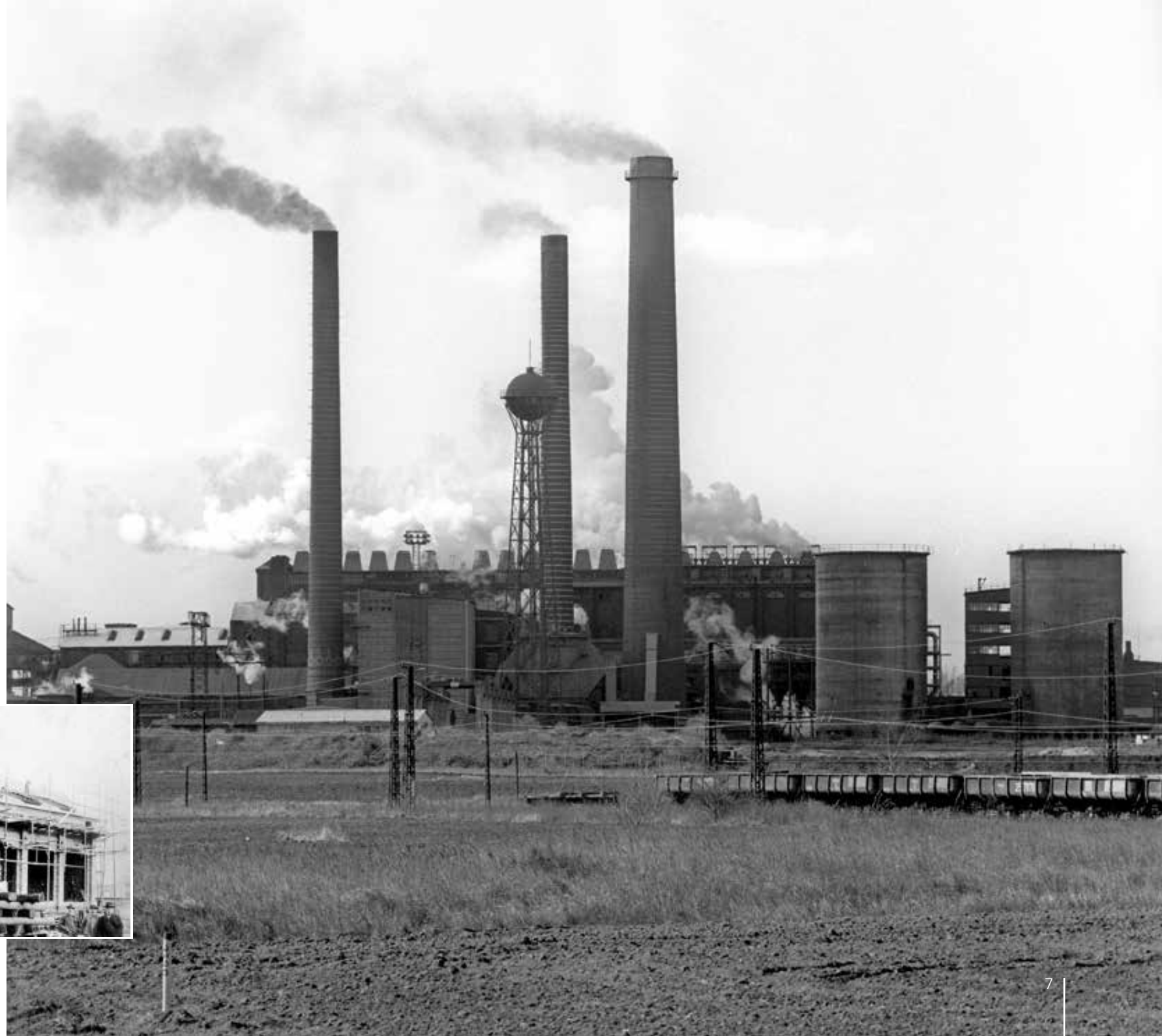
Brikettfabrik „Kraft II“ des Braunkohlenwerkes Borna in Deutzen, im Bildmittelpunkt: die Wasserkugel, die heute noch steht, 1991
