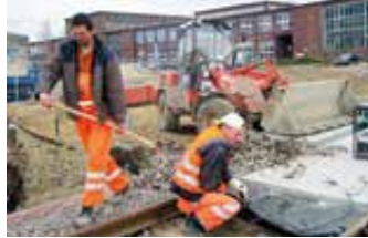
Baumaßnahmen im entstehenden Industriepark Espenhain, 2004
