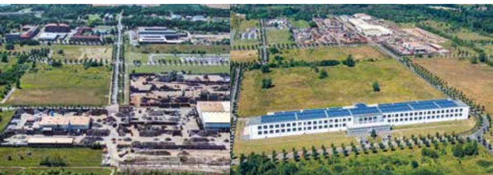
Dienstleister im Industriepark Espenhain, 2005 Recyclingunternehmen im Industriepark Espenhain, 2019 Schaltwarte Espenhain, 2019
