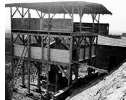
Nasspresse in der Grube Bocka, altes Verfahren als Notlösung in der Nachkriegszeit, um 1950
