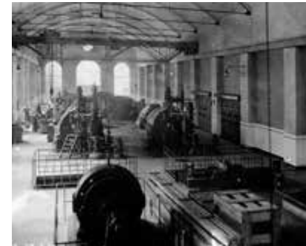
Turbinensaal der Kraftzentrale des Braunkohlenwerkes Deutzen, 1928 Kraftwerk Böhlen, 1930er Jahre
