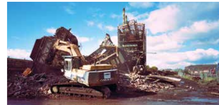
Abbrucharbeiten an der Schwelerei II am Veredlungsstandort Espenhain, 1997 Sprengung der Brikettfabrik I am Veredlungsstandort Espenhain, 2002
