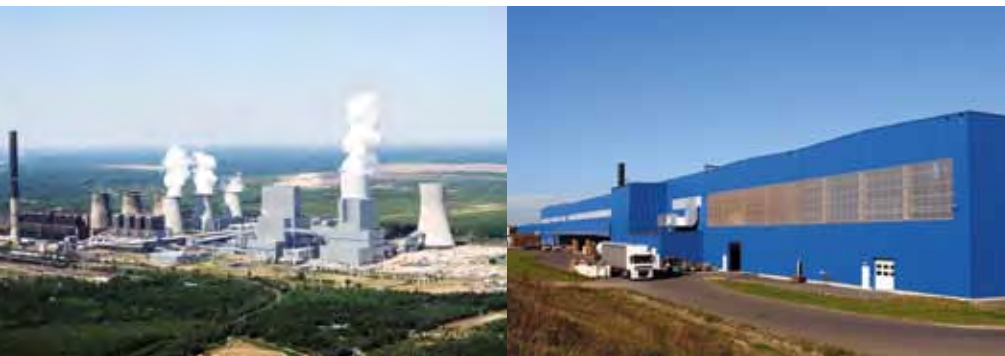
Photovoltaikanlagen des Solarkraftwerks Laubusch, 2011 Altes Kraftwerk (links) und Neubaukraftwerk (rechts) am Standort Boxberg, 2010 Produktionshalle des Gießereiwerks in Sabrodt, 2011
