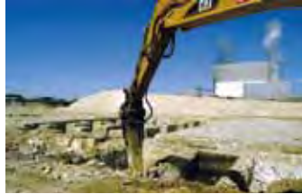
Abbrucharbeiten in Schwarze Pumpe, 2003
