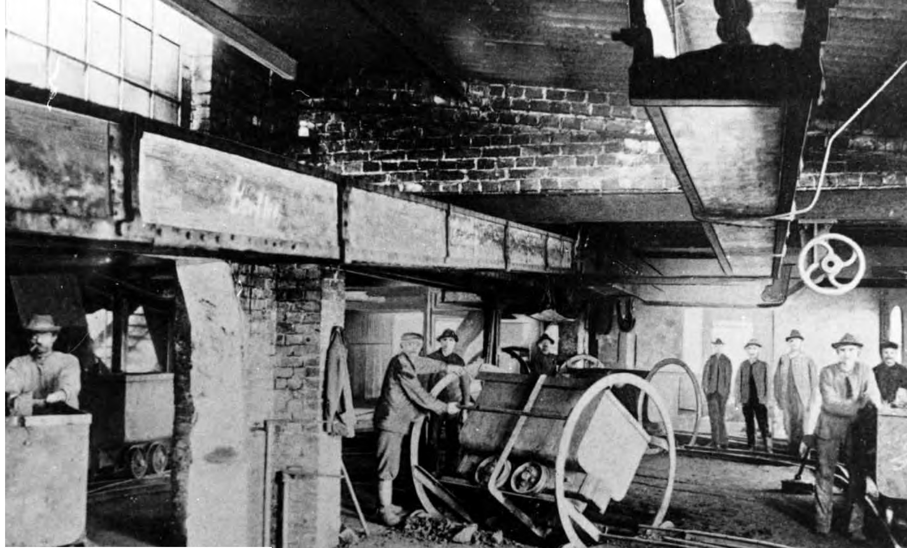
Kreisel-Wipperanlage der Kohlenverteilerstelle in einer Lausitzer Briкетtfabrik, um 1910
