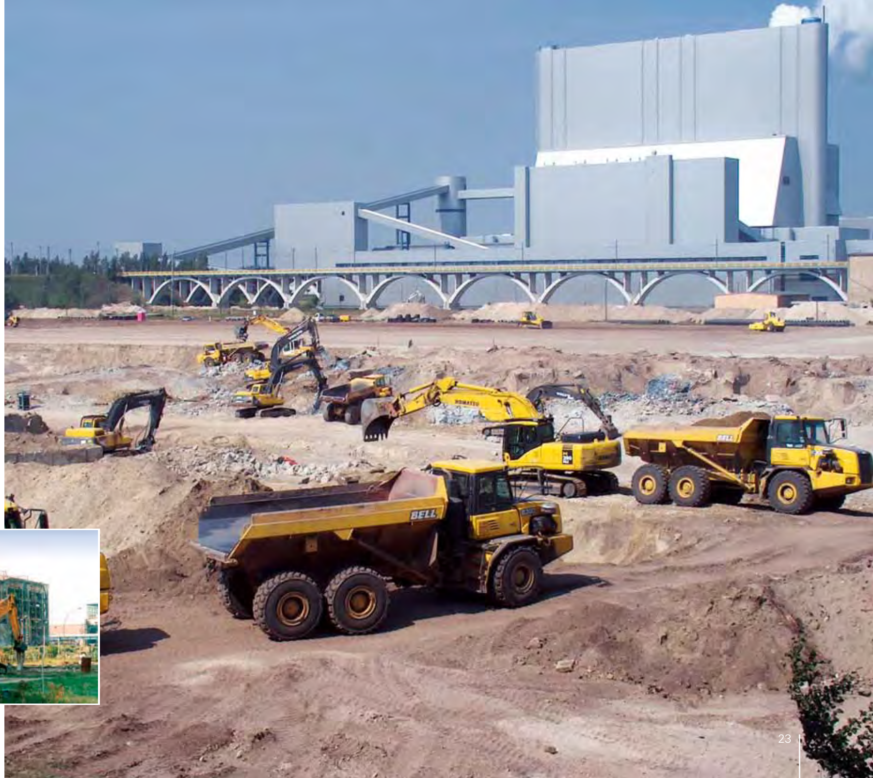
Tiefenentrümmerung im entstehenden Industriepark Schwarze Pumpe im Bereich der Kraftwerke Mitte und Ost, 2003
