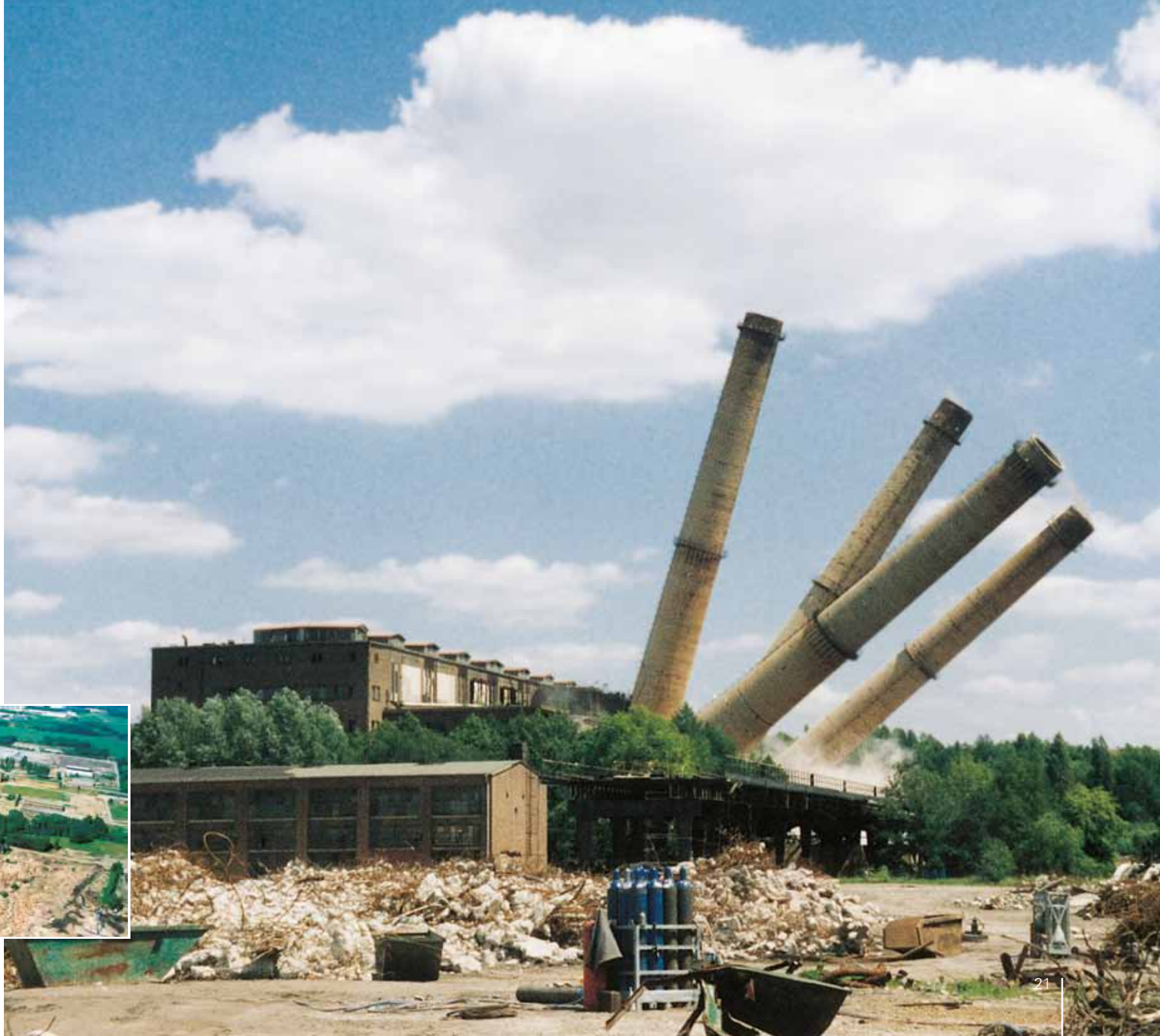
Sprengung der Schornsteine des Kraftwerks Trattendorf, 1998
