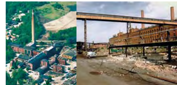
Beräumte Fläche der ehemaligen Brikettfabrik Zeißholz, 2006
