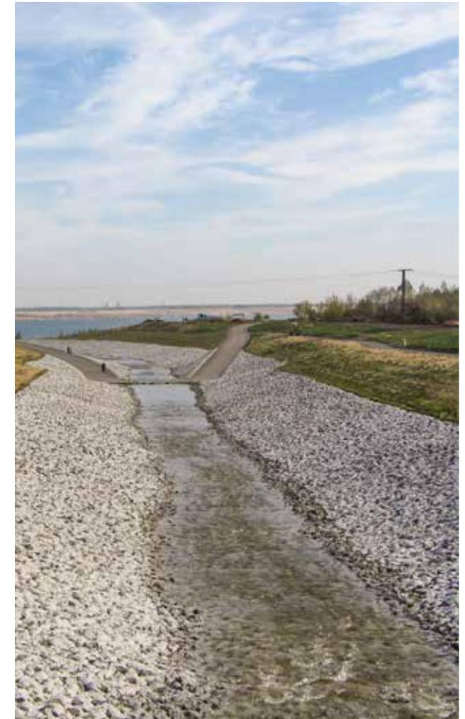
Am 9. März 2007 begann die schnelle Flutung des Tagebaurestloches Zwenkau auf Basis einer Entscheidung der Landesdirektion Leipzig vom 15. Dezember 2006 zum vorzeitigen Beginn nach § 31 WHG. Damit wurde zunächst die Einleitung von ~15 m<sup>3</sup>/min Sumpfungswasser bei einer Kapazität von bis zu 45 m<sup>3</sup>/min aus dem Tagebau Profen bis zum Erreichen eines Wasserstandes von +94 m NHN möglich, April 2007.
