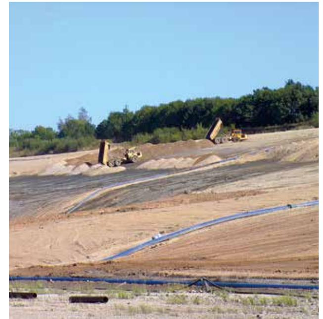
*Kiesauftrag auf die abgeflachte gewachsene Böschung der Westausfahrt und Wasserableitung, August 2004*
