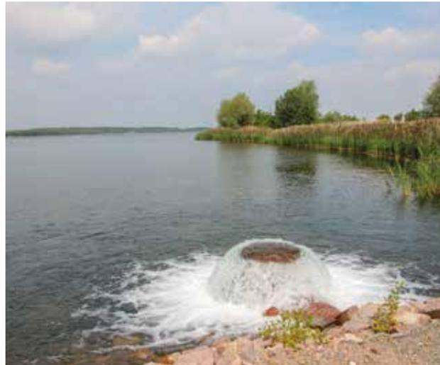
*Derzeitige provisorische Überschusswasserableitung vom Zwenkauer in den Cospudener See zum Halten eines bauzeitlich geotechnisch erforderlichen Wasserstandes im Zwenkauer See von +112,5 m NHN, also 1 m unter dem Zielwasserstand, August 2017.*
