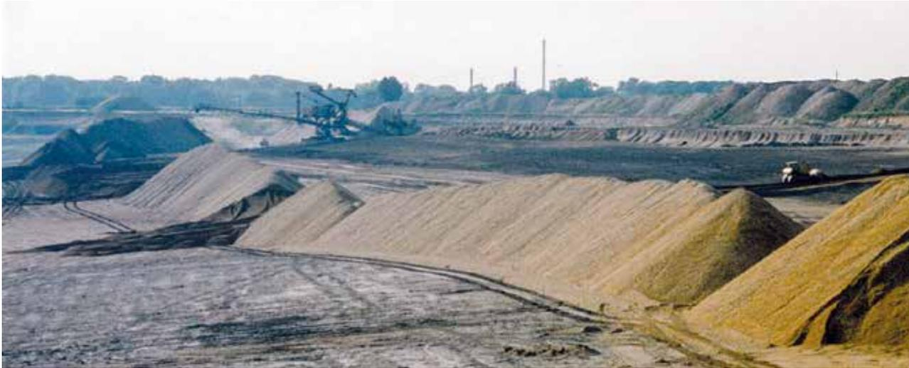
Die gewachsenen Nordböschungen im Oberabraum wurden 1992 mit Blick auf eine frühzeitig zu ermöglichende Nutzung per Planiertrappen auf eine Neigung von 1:10 abgeflacht. Durch Einsatz der Direktverstürzkombination Bagger 1529 und Bandwagen BRs 1400 konnte Kies aus dem ehemaligen 1. Abraumschnitt umgesetzt und durch Planiertrappen 1 m mächtig aufgetragen werden.
