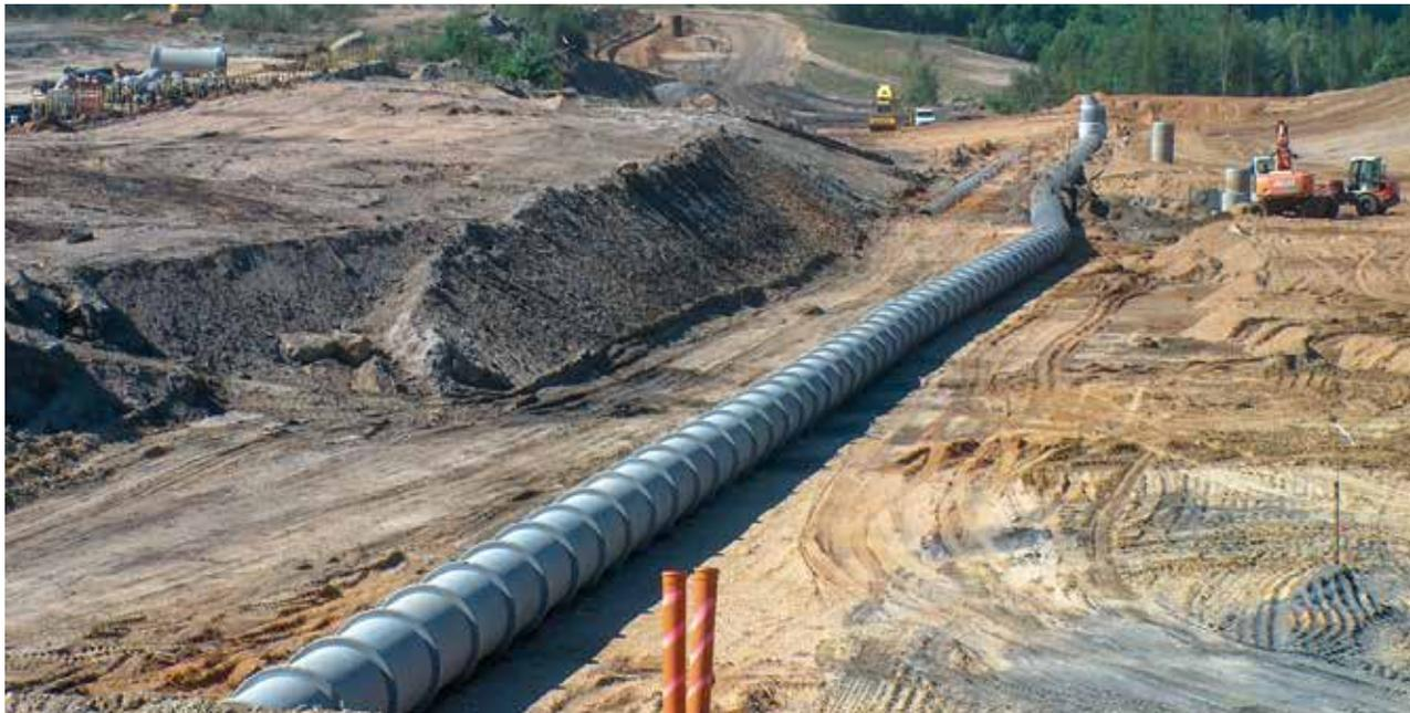
*Herstellung eines Drainagekörpers im Bereich der Westausfahrt zur ungehinderten Grundwasserableitung in Richtung Hauptwasserhaltung bis zum Böschungsüberstau durch die Flutung, August 2004*
