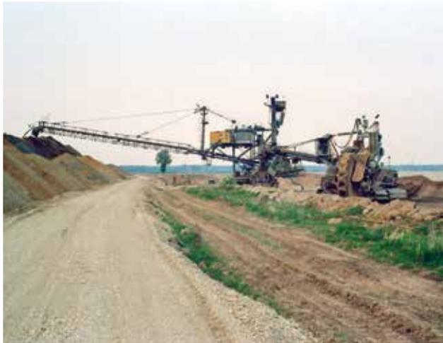
Grobabflachung des Westböschungssystems durch Einsatz der Direktversturzkombination Bagger 1529 und Bandwagen BRs 1400, 1993
