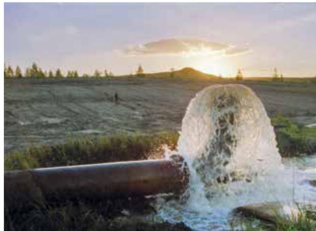
Fremdwasserzufuhr aus dem Tagebau Zwenkau unterhalb der Bistumshöhe beschleunigte die Flutung des Tagebaurestloches zum Cospudener See, 1997.
