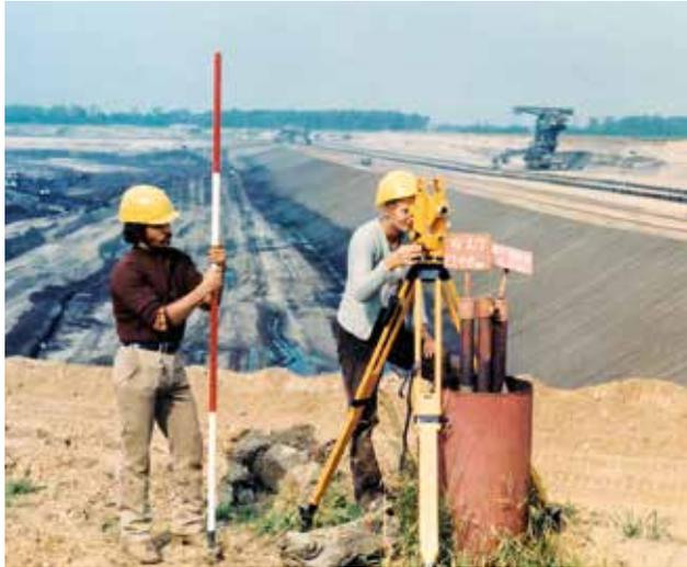
Vermessungsarbeiten für die Auslaufplanung Tagebau Cospuden, 1990
