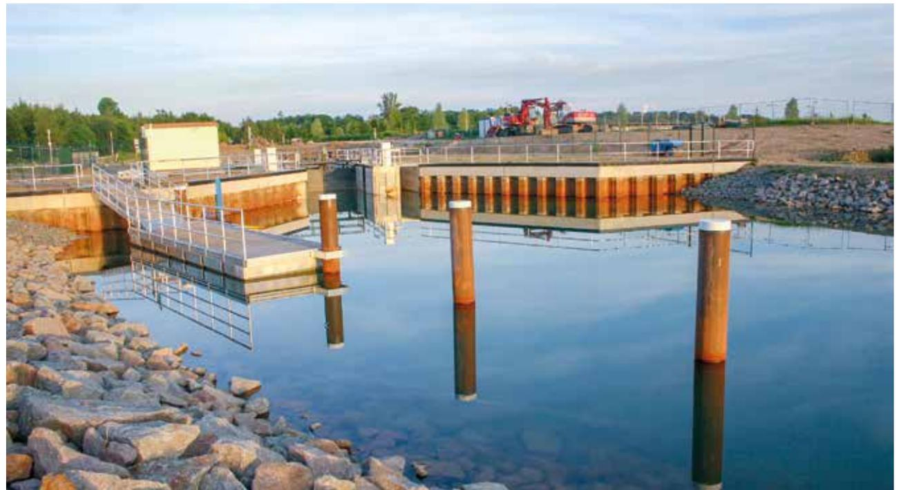
*Mit der Fertigstellung des kombinierten Schleusen- und Wehrbauwerkes im Überschusswasserableitkanal am nördlichen Rand des Cospudener Sees 2006 und der Ablösung zweier Rohrleitungen unter der S 46 durch eine Brücke mit offenen Kanalstück 2010 konnte der See an das Leipziger Gewässernetz bootsgängig angeschlossen werden, Juni 2006.*
