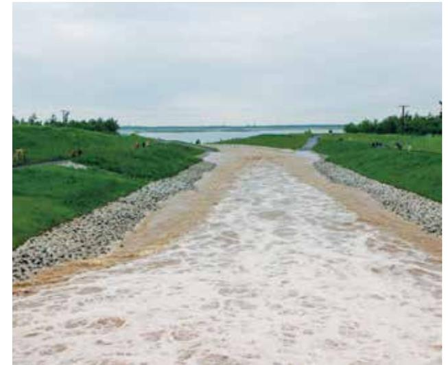
Bis zu 138 m³/s werden aus der Hochwasserwelle der Weißen Elster am 3. Juni 2013 in das Tagebaurestloch Zwenkau eingeleitet, 2013
