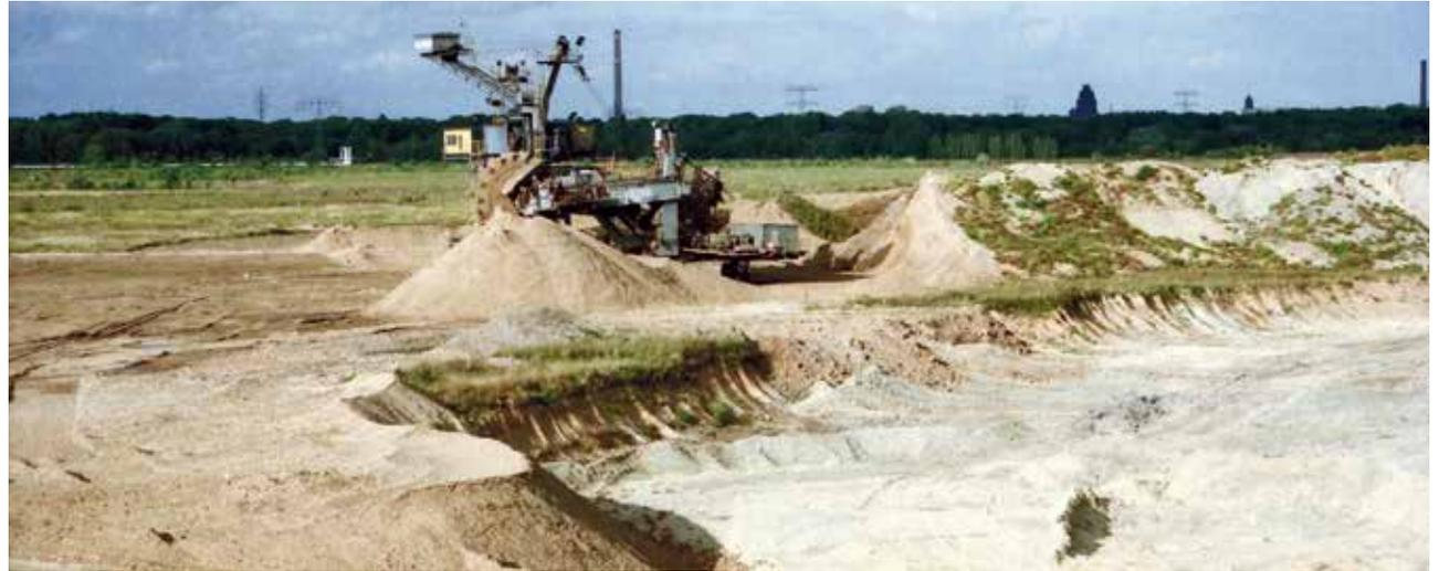
Kulturboden- und Kiesgewinnung aus dem stillgelegten 1. Abraumschnitt mit Bagger 1529 SRs 400 und Bandwagen 820 BRs 1400 zur Böschungsgestaltung der Nordböschung, 1992
