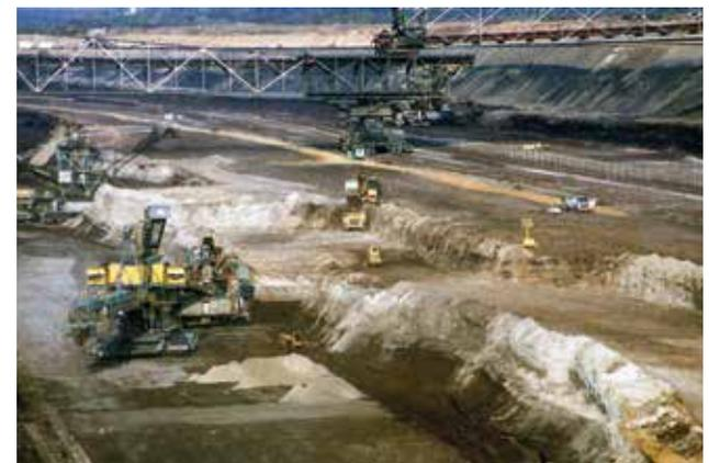
*In Abstimmung mit der Tagebauverpächterin LMBV stellte die MIBRAG mbH die Abraumgewinnung im Mittelabraum teilweise auf Schwerlast-LKW-Förderung (Truckbetrieb) um. Dadurch wurde die Schließung des nordwestlichen Randschlauchs optimiert und setzungsfließempfindliche Flusssande konnten sicher eingespannt werden, 1997.*
