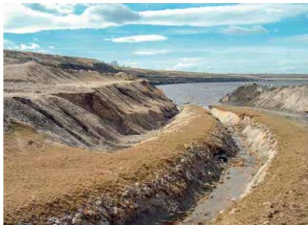
*Durch die ab 2006 erlaubte Zuleitung des gesamten Filterbrunnen- und Oberflachenwassers wird der Grubenwasser-ruckhaltedamm schnell uberstaut, April 2006.*
