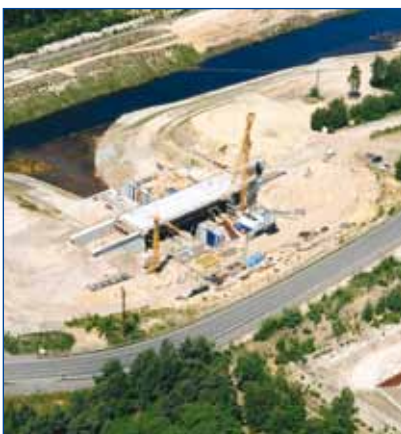
Bau des Kanals auf der Seite des Partwitzer Sees
