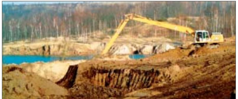
Hydraulikbagger beim Umsetzen der Erdmassen aus dem Sicherheitsbereich.
