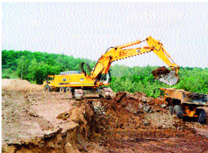
Mitarbeiter der Firma Meister bei Erdbauarbeiten zur Neugestaltung der Südböschung von Holzweißig-Ost
