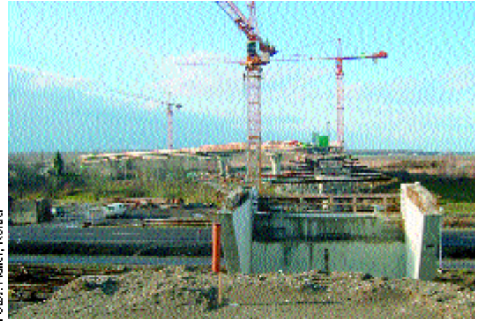
Der geschüttete Damm auf bereits verwahrtem Gelände im Vordergrund sichert die Anbindung zum Brückenbauwerk.
