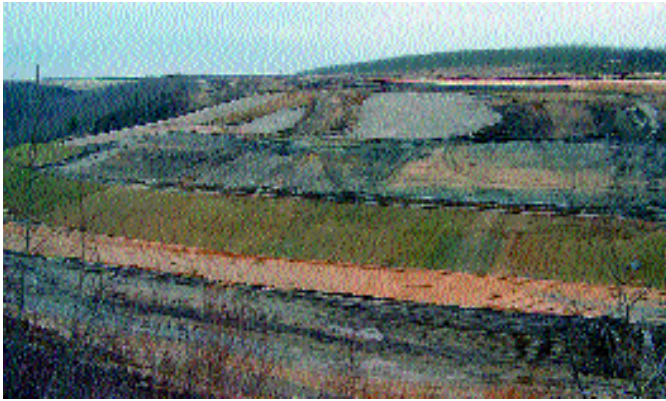
Die Kippenböschung nach der Sanierung im Dezember 2004
