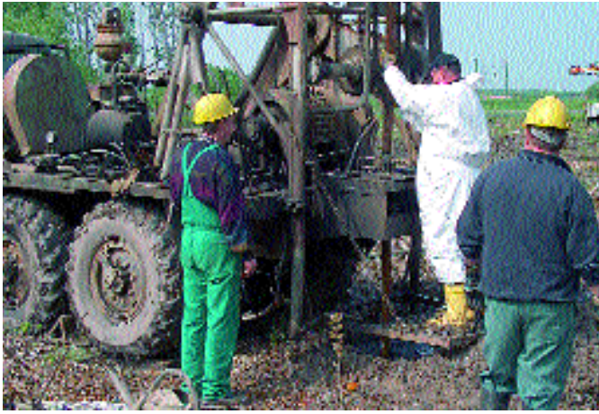
Mitarbeiter der Frankfurter Firma beim Abteufen von Versatzbohrungen auf das Entwässerungssystem des Altagebaus Espenhain
