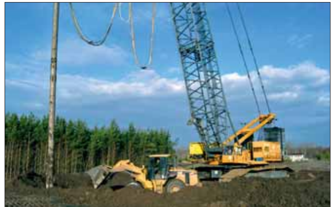
Altdöberner See: Der Boden für den künftigen Auslauf wird gesichert.
