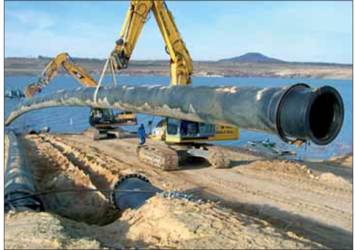
16. Januar: Die Steinle-Bau-Mitarbeiter um Werner Schuster entnehmen ein weiteres 50-Meter-Segment aus der Neißeflutungsleitung.
