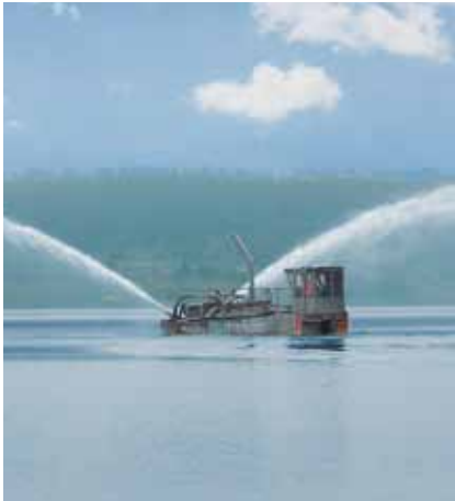
Erstes Sanierungsschiff in Aktion
