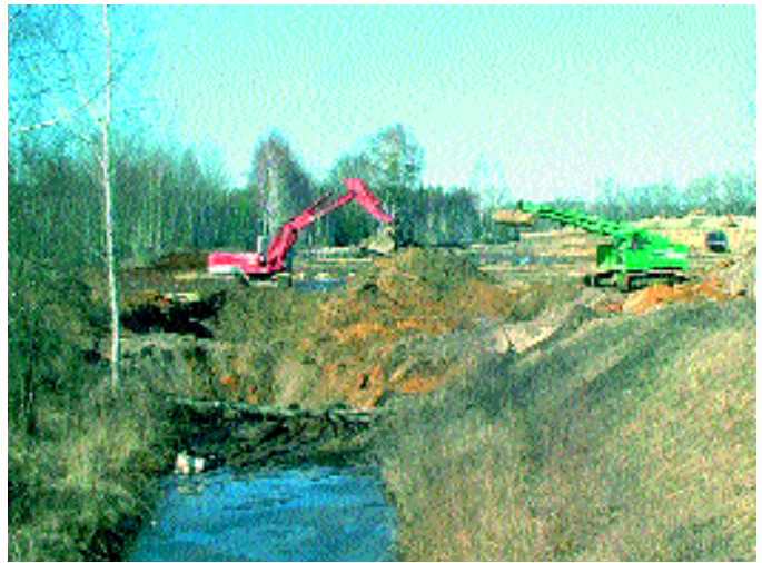
Mitarbeiter der Bul Sachsen leiten im Auftrag der LMBV die Rainitza um. Hier ein Blick auf die Arbeiten im südlichen Bereich.
