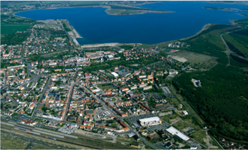
Zwischen Bitterfelder Berg (im Bild rechts außen) und Strengbach entsteht eine Dichtwand
