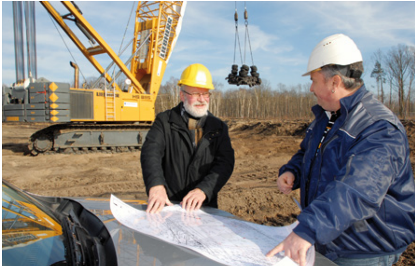
Bauberatung für die Fallgewichtsverdichtung auf dem künftigen SeeCampus in Schwarzheide
