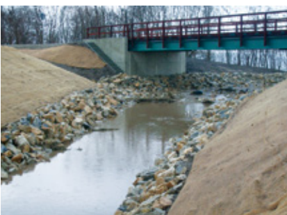
Einlaufbauwerk der Stöbnitz in Mücheln
