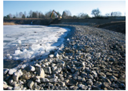
Steinschüttung an Otts Loch als Stützpfeiler
