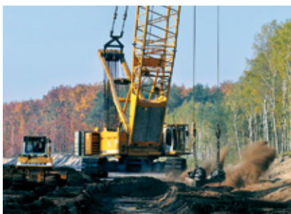
Fallplattenverdichtung auf Überleitertrasse
