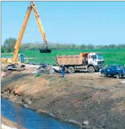
Bis Ende des Jahres vertiefen Mitarbeiter der Firma ECOSOIL Ost GmbH im Auftrag der LMBV die Leine bei Bitterfeld. Die Maßnahme sichert das Ableiten von Überschusswasser aus der Goitzsche über + 75,0 m NN.
