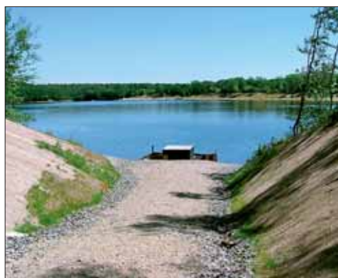
Durch das Auslaufbauwerk fließt das Überschusswasser in die unterirdische Freispiegelableitung.
