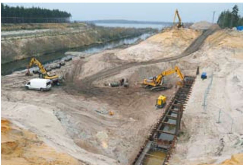
Arbeiten am Überleiter 6, dem Verbindungskanal zwischen Neuwieser (ehem. Tagebau Bluno) und Partwitzer See (ehem. Tagebau Skado). Geplant sind hier ein 428 Meter langer Kanal mit Einkammerschleuse, Fischtreppe, Rohrleitung, Straßenbrücke und zwei Vorhöfen
