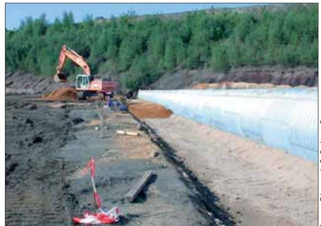
Ein Stahlrohr im Durchmesser von 2,22 Metern sichert weiter den Zugang zu den Strecken.
