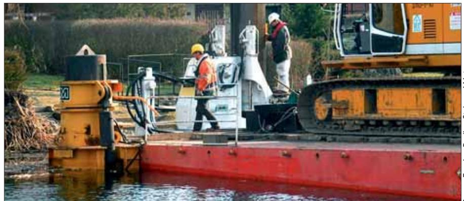
Mit dem Setzen einer Spundwand sichern Mitarbeiter der BUL Sachsen im Auftrag der LMBV das Ufer des Tagebaurestloches Gerlebock-Süd im Landkreis Bernburg.
