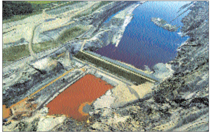
Zwenkaus Grube mit Wasserhaltung und Grubenwasser-Rückhaltedamm
