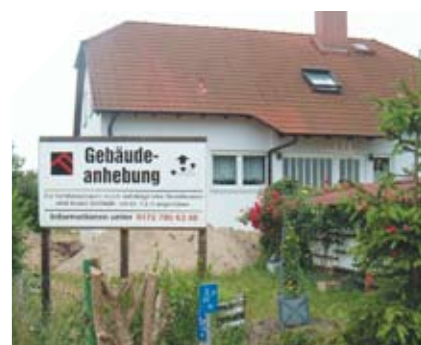
Vorbereitung zum Anheben des Wohnhauses
