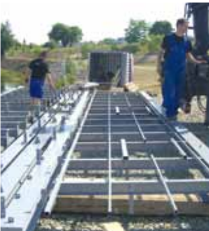
Am Ufer vormontiert: die Tragekonstruktion.
