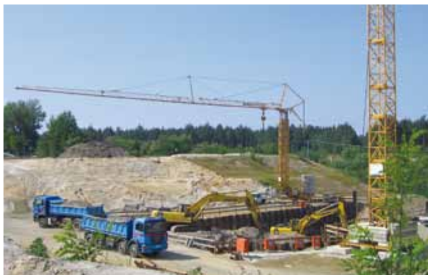
Innerhalb der Spundwände entsteht das Schleusenbauwerk des Überleiters 6.
