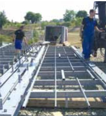
*Am Ufer vormontiert: die Tragekonstruktion.*
