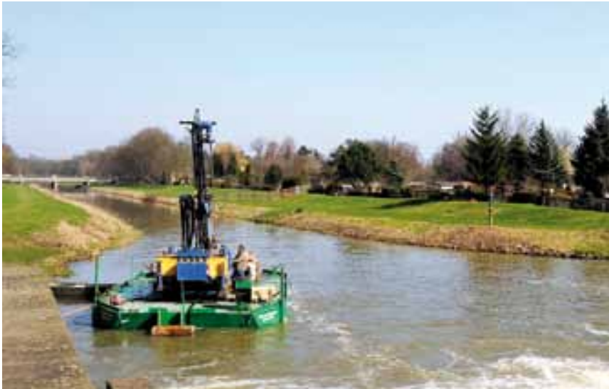
Vorarbeiten für die Schleuse: Bauvorbereitende Gründungsbohrungen am Connewitzer Wehr.
