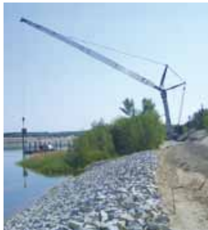
Ein Kran bereitete den „Ankerplatz“ vor.
