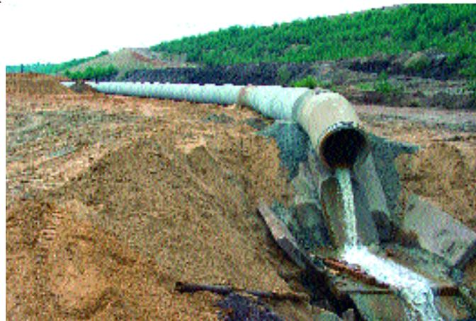
Teil der 1509 Meter langen und ein Meter starken Betonrohrleitung
