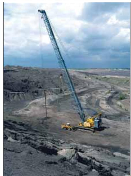
Allein 905 000 Kubikmeter Kippenboden im Restschlauch sowie am Drehpunkt der Abraumförderbrücke sichern Mitarbeiter der BUL Sachsen per Rütteldruckverdichtung.
