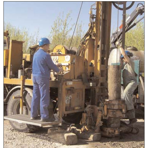
Bis zu 13 Meter tief werden die Pegel gebohrt.
