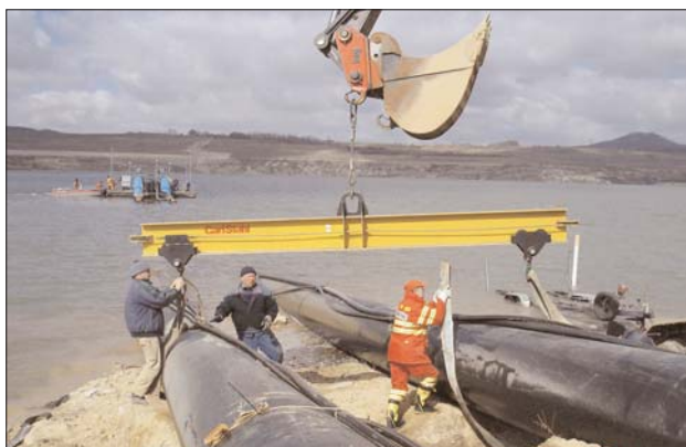
Der Berzdorfer See ist zu rund einem Drittel mit Wasser aus Pließnitz und Neißer gefüllt. Im April verkürzten Löbauer Steinle Bau-Mitarbeiter schon zum fünften Mal die Flutungsleitung aus der Neißer.
