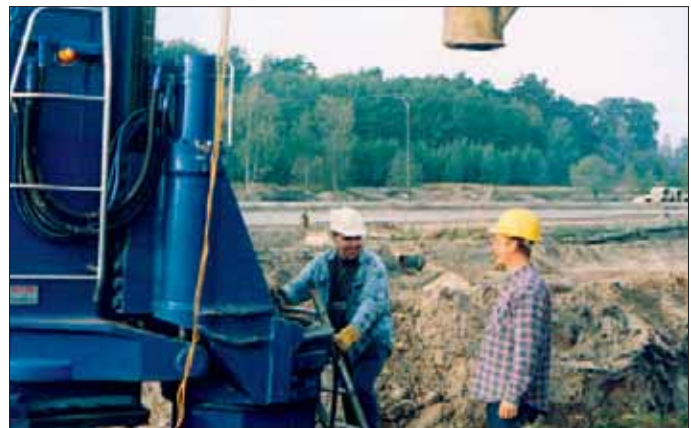
Dietmar Seidel und René Schneider vom Spezialtiefbau Cottbus präsentieren für den Boblitzer Auftragnehmer die Spundwand.
