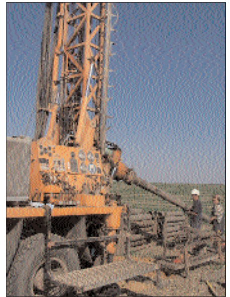
Mitarbeiter der Firma Geomechanik Sachsen aus Tauscha führen die Erkundungsarbeiten in Projekträgerschaft der LMBV aus.
