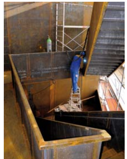
Innenarbeiten an der Landmarke gehen voran
