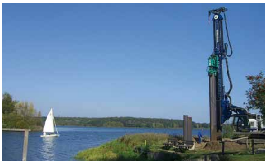
Am Groß Särchener Ufer des Knappensees entsteht zu Sicherheitszwecken eine Spundwand.
