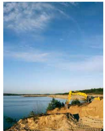
Partwitzer See. An der Südböschung des Partwitzer Sees gehen die Gestaltungsarbeiten auch im Winterhalbjahr mit unverminderter Geschwindigkeit weiter. Mit mobiler Erdbautechnik werden lange Uferbereiche für die Nachnutzung profiliert.
