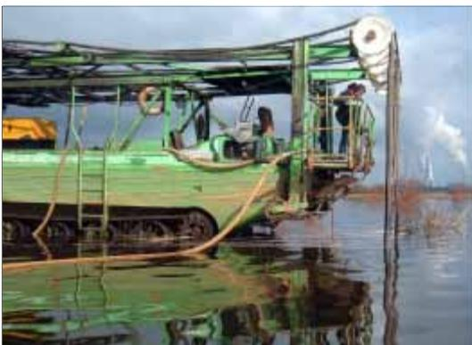
**Uhyst.** Bis sechs Meter tief werden Flachwasser- und Uferbereiche des Bärwalder Sees in Ortsnähe leicht rütteldruckverdichtet. Ziel ist das Herstellen der Trittsicherheit sowie das Beseitigen noch vorhandener Überhöhen einzelner Inselbereiche.
