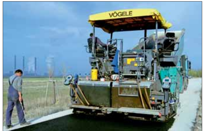
Meter für Meter wächst gegenwärtig der Rundweg um den See.
