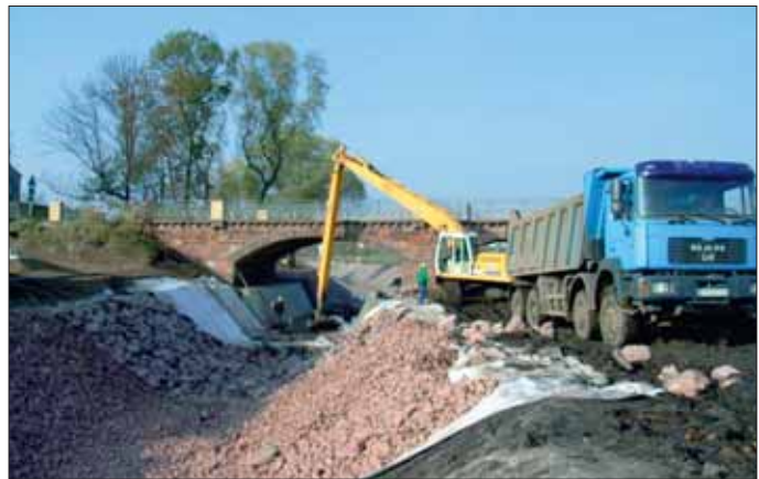
Ecosoil-Ost-Mitarbeiter sichern die Fundamente auch für die Berliner Brücke.
