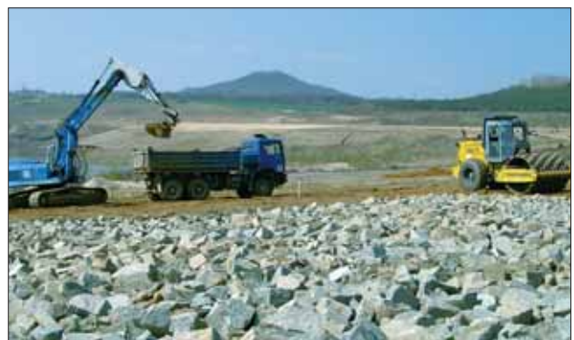
Uferprofilierung im Bereich des ehemaligen Ortes Deutsch Ossig: Hier entsteht ein Plateau für den künftigen Campingplatz.
