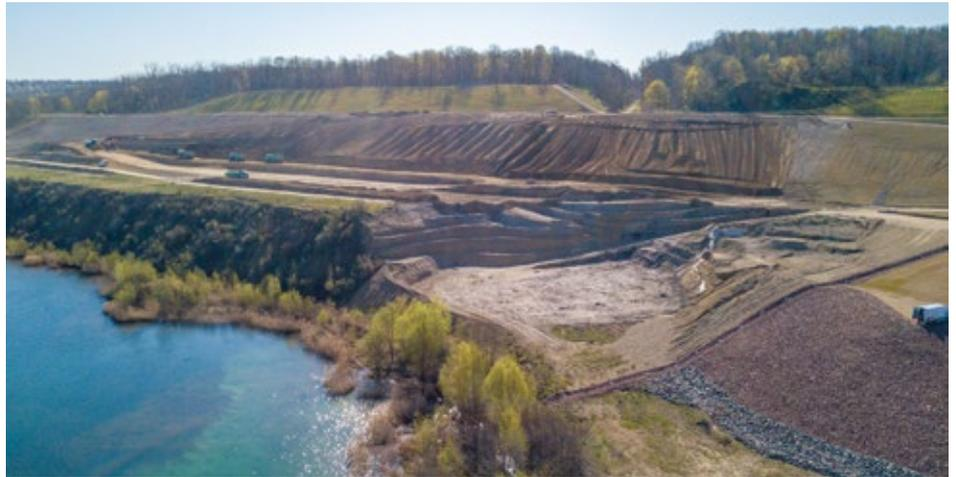
*Erdbautechnische Aufweitungsbereiche zum Abtrag der östlichen Rutschungsflanke (im Hintergrund) und Sprengfeldfläche (im Zentrum) im Sanierungstagebau Nachterstedt*
