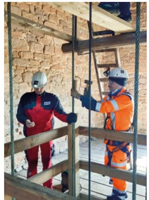
Abnahme durch den Sachverständigen und Prüfung der Seilspannkraft
