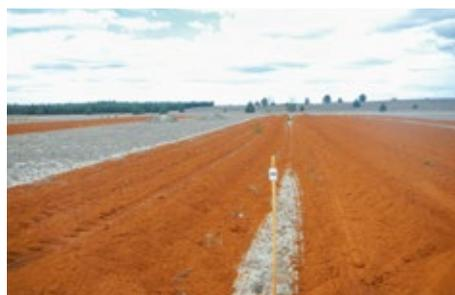
Ausbringung von Eisenhydroxidschlamm im Bereich des Sanierungstagebaus Spreetal
