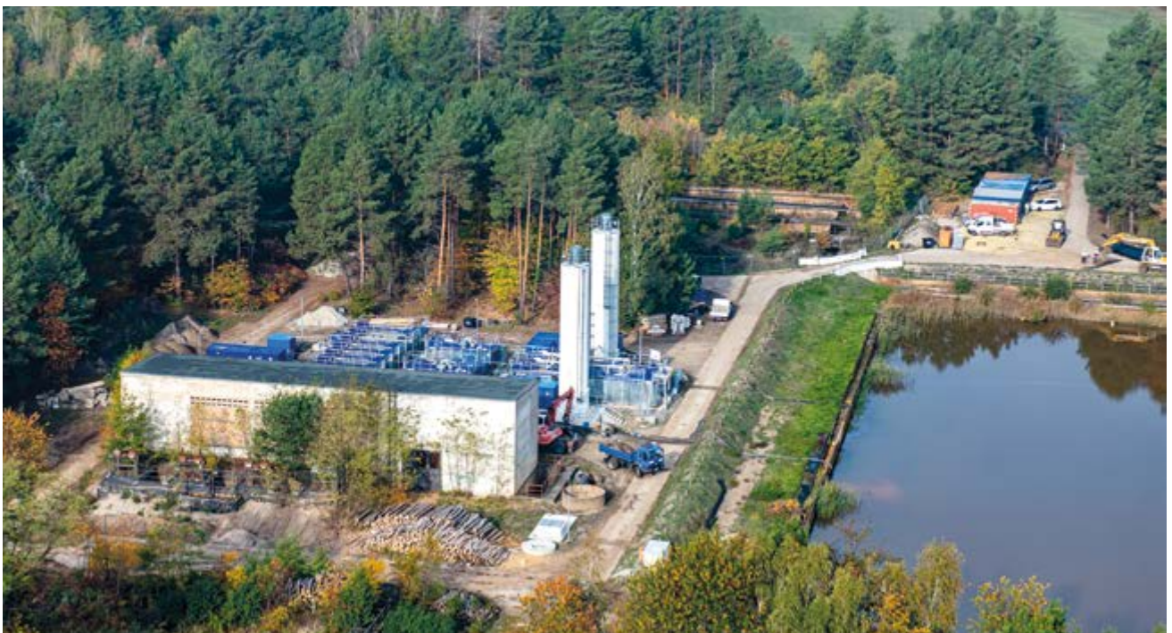
Wasserbehandlungsanlage Burgneudorf im Bereich der Kleinen Spree
