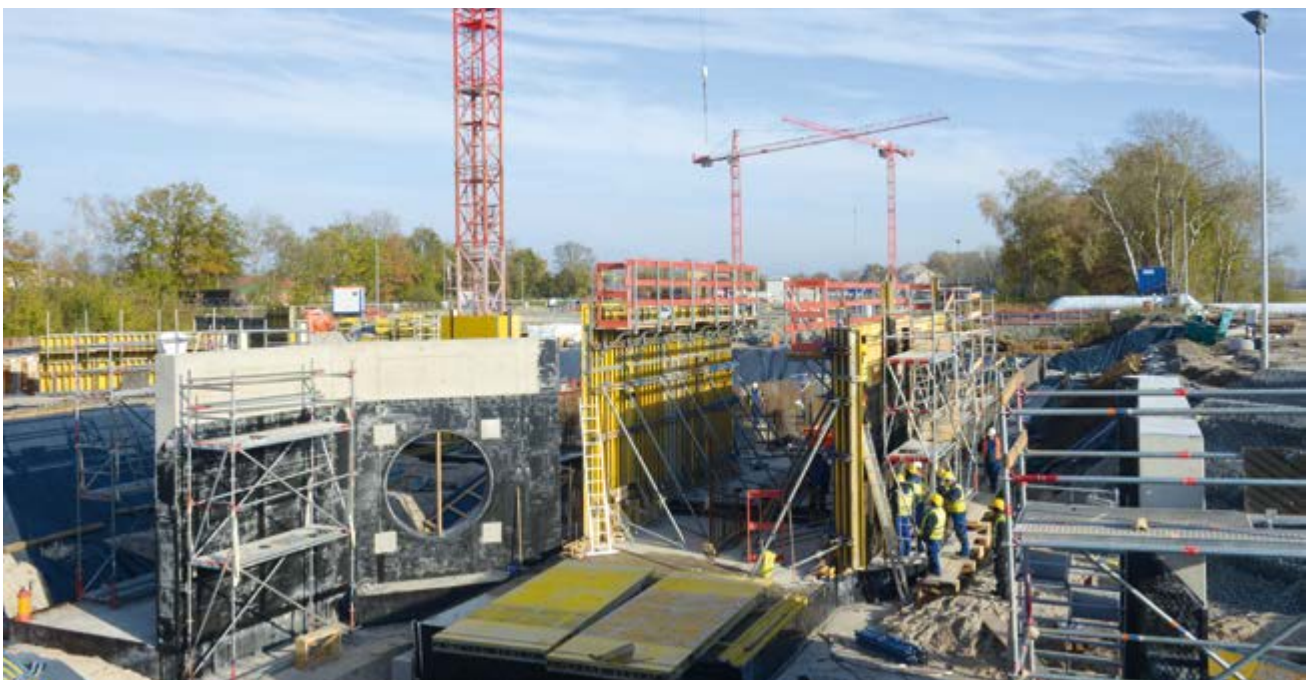
Baufortschritt auf der Baustelle der WBA Plessa im November 2020
