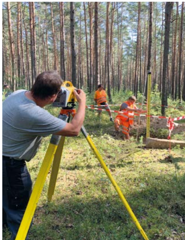
Vermessungsarbeiten in Sachsen
