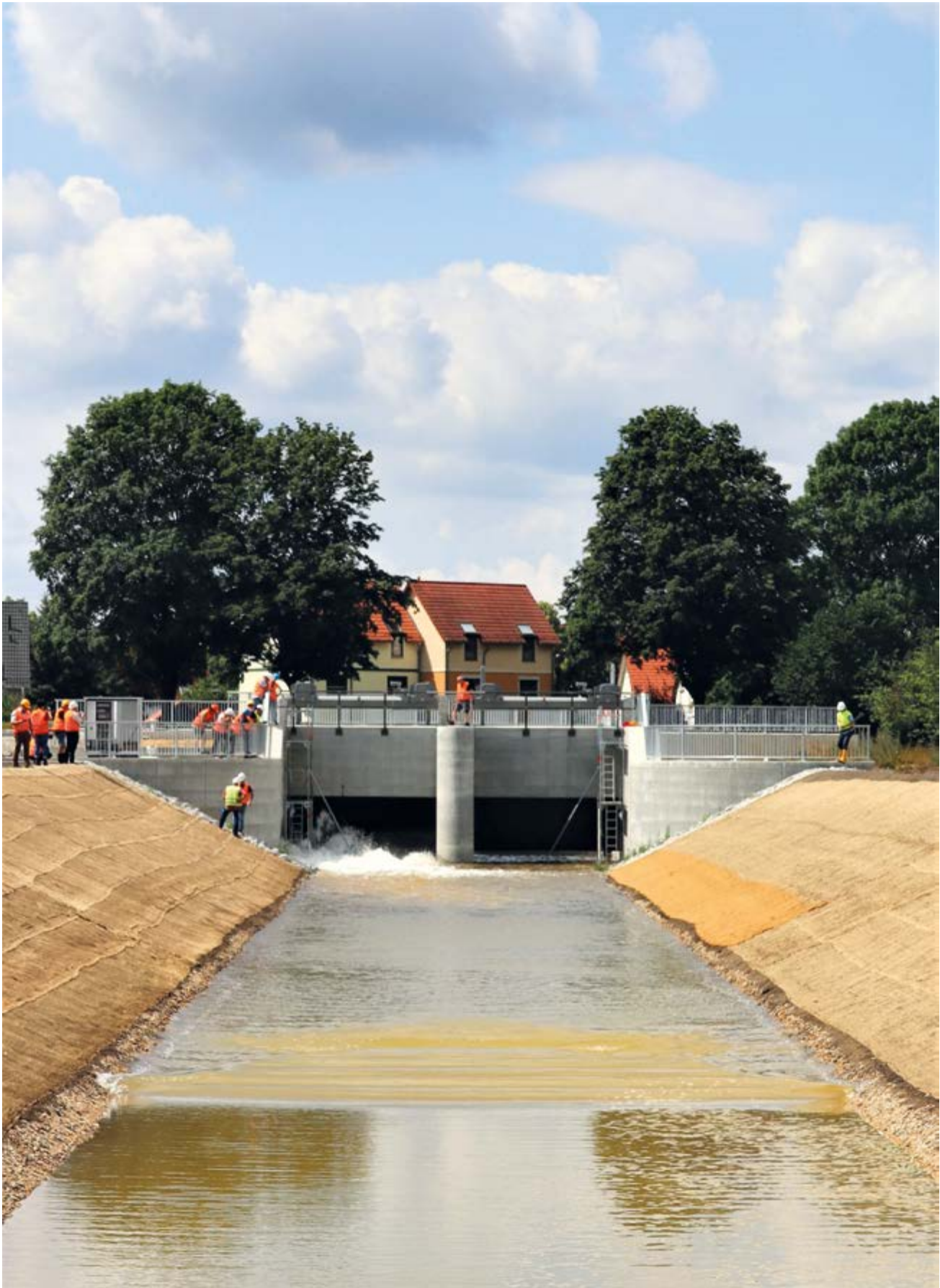
Nassabnahme für das Siegel am Ableiter Sedlitz
