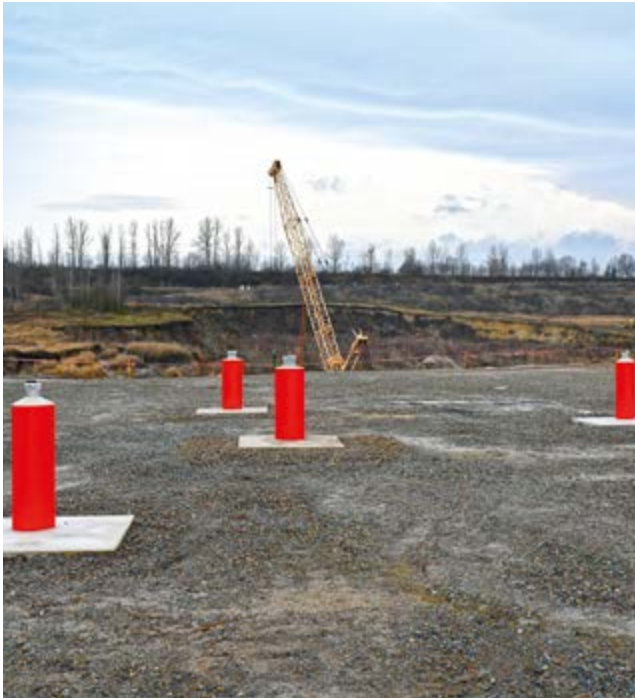
Filterbrunnen im Bereich des Rutschungskessel am Concordia See
