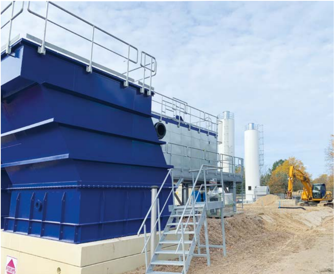
Erichtung der Wasserbehandlungsanlage Ruhlmühle
