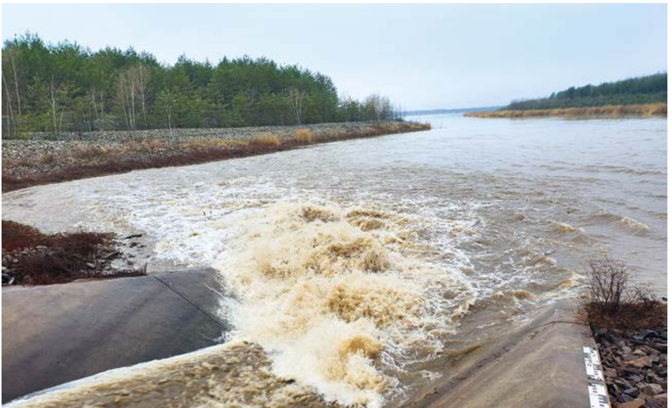
Spreewasser schießt mit 6,2 m³/s über die Absturzrampe ins Speicherbecken Lohsa II
