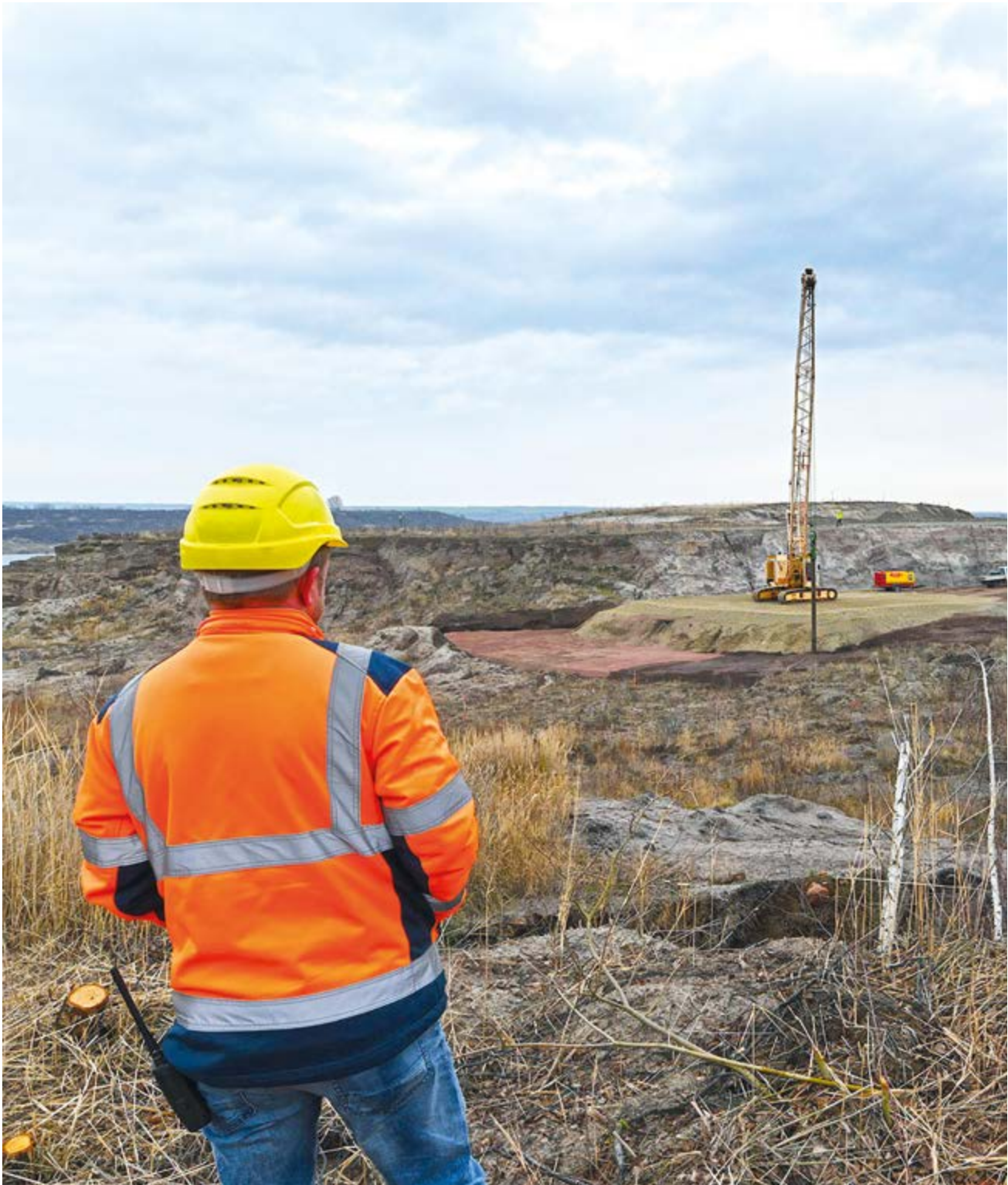
Rütteldruckverdichtung im Sanierungstagebau Nachterstedt
