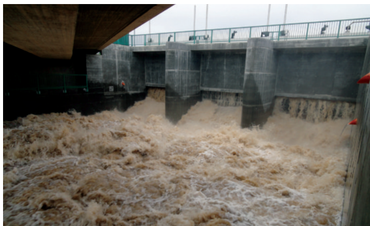
Abb. 1.7. Hochwassereinlaufbauwerk von der Weißen Elster zum Zwenkauer See im Juni 2013
