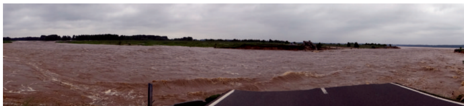
Abb. 1.8. Muldedurchbruch 2013 in den Seelhausener See mit Zerstörung der Staatsstraße 12 Foto: A. Berkner
