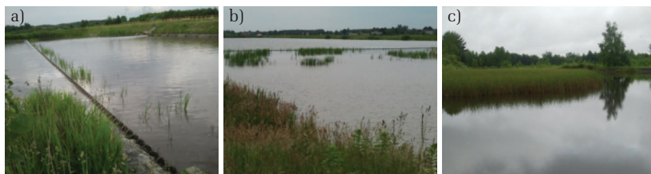
Abb. 7.2. Teile der Beckenkammer im KWB Bełchatów: a) Vorklärbecken, b) Nachklärbecken, c) Pflanzenfilterzone Foto: A. Goździewska
