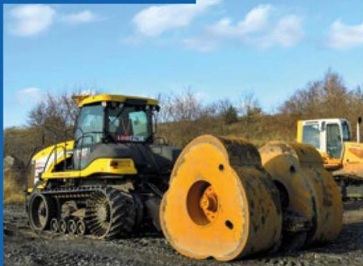
Für die Oberflächenverdichtung kommt eine spezielle Polygonwalze zum Einsatz. Diese Walze wird über die Fläche gezogen, die maximale Verdichtungstiefe beträgt dabei zwischen 3 und 5 Meter.
