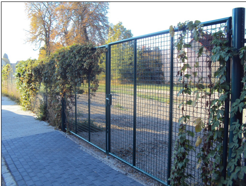
Abb.2 Blick auf den Eingangsbereich Alte Bockwitzer Straße 2.
