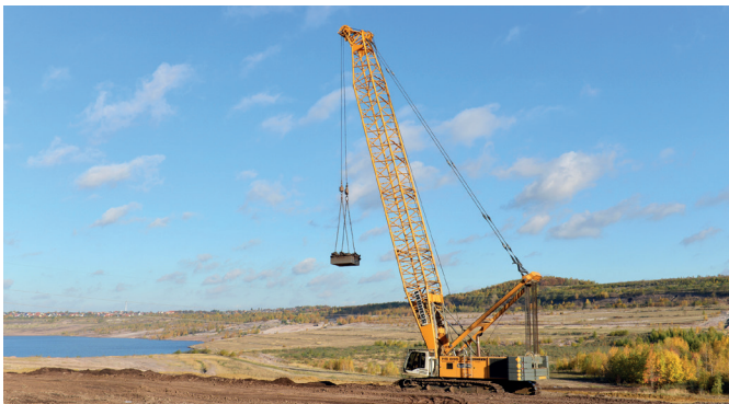
Fallplattenverdichtung im ehemaligen Tagebauegebiet Wulfersdorf
