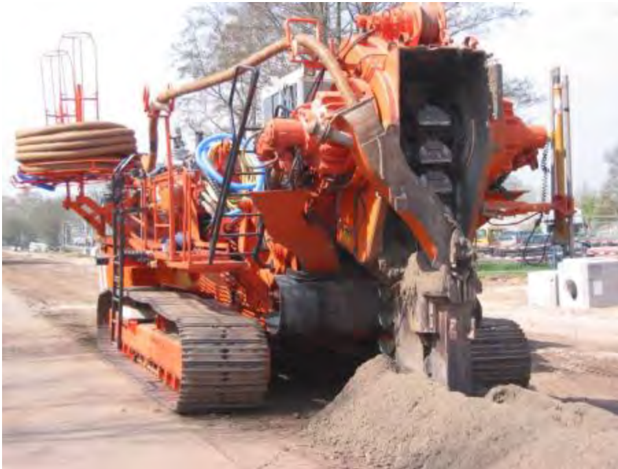
Abbildung 8.10 Maschinelle Verlegung von Drainagerohren, Dränagefräse Quelle: http://upload.wikimedia.org/wikipedia/commons/e/e6/Drainage_machine_voor_horizontale_drainage.jpg
