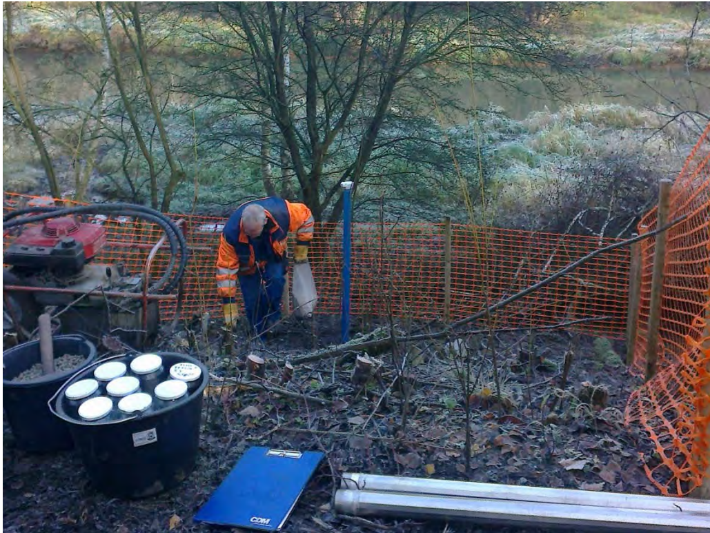
Abbildung 5.5 Foto: Errichtung eines Überflurpegels im Böschungsbereich
