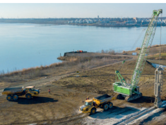
Bau der Dichtwand am Harthkanal
