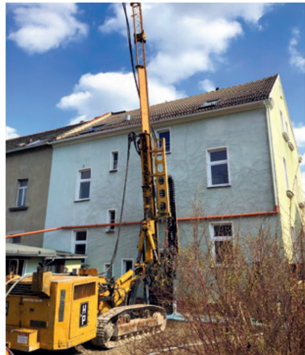
Bohrfahrzeug zur Erstellung der HDI-Bohrungen
