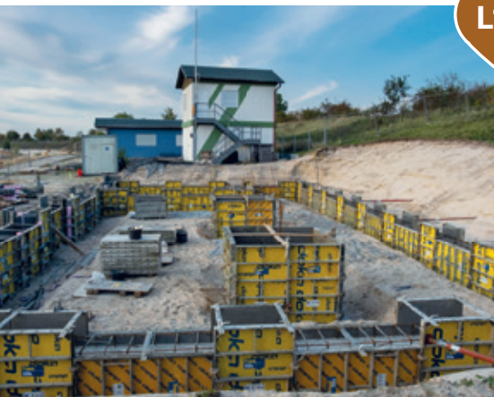
Bootshaus am Geierswalder See im Bau
