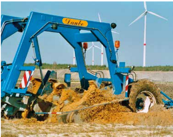
Wprowadzanie wapna za pomocą głębokiej obrotowej motyki łopatkowej
