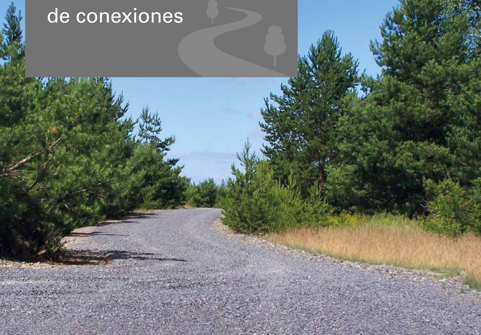
Camino de servicio en el área recultivado de la mina lignite a cielo abierto Nochten
