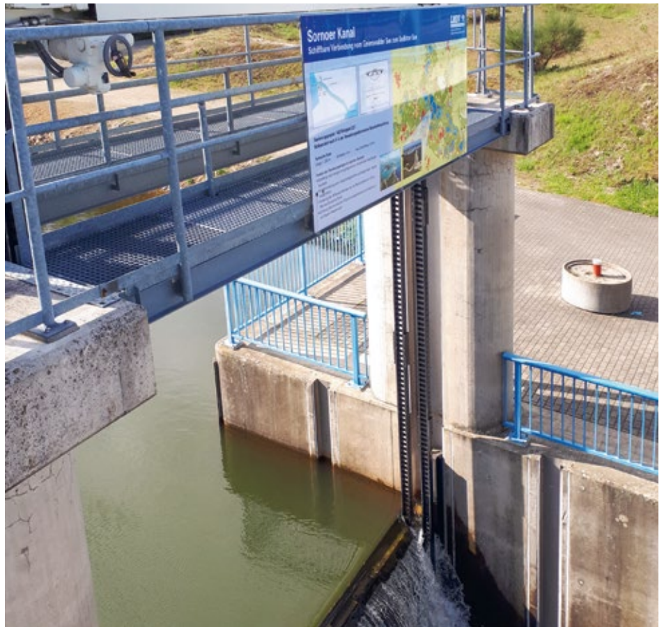
Dank ausreichender Niederschläge konnte der Sedlitzer See auch über den Überleiter 10 (Sornoer Kanal) weiter geflutet werden.
