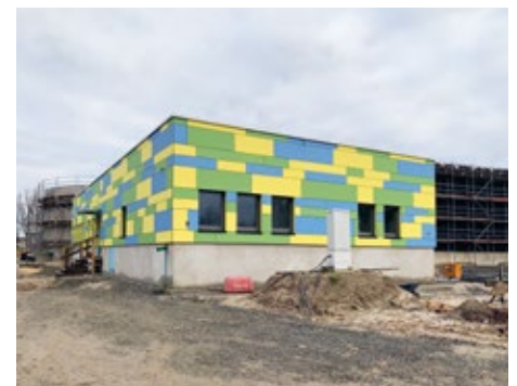
Betriebszentrale mit gestalteter Fassadenvorhängung
