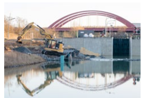
Bau des Stützkörpers im unteren Vorhafen
