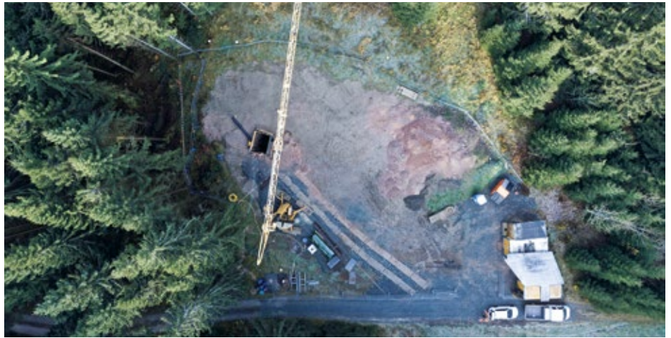
Blick auf die Baustelle mit Vorteeufe, über welche der Tagesbruch mit Beton verfüllt wird
