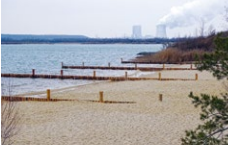
Sanierter Uferbereich am Nordufer mit Kiesschüttung und Holzbohlen
