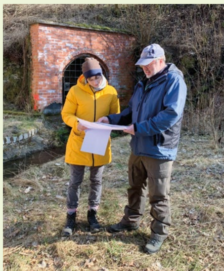
Am Mundloch des alten Steinbachstollens
