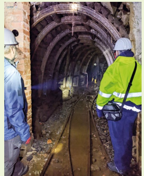
Eindrucksvoll: Der auf dem Gelände der Firma Berg in Brotterode-Trusetal liegende Wasserlösestollen – aus dem Reservoir der zusitzenden Wässer wird dort unter anderem auch die Trinkwasserversorgung für das gesamte Trusetal sichergestellt.
