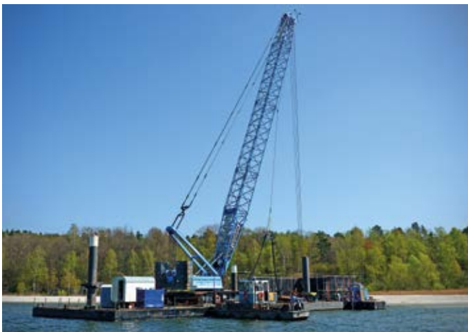
Seeseitige Rütteldruckverdichtung in den Bereichen T und S-Nord, 2017
