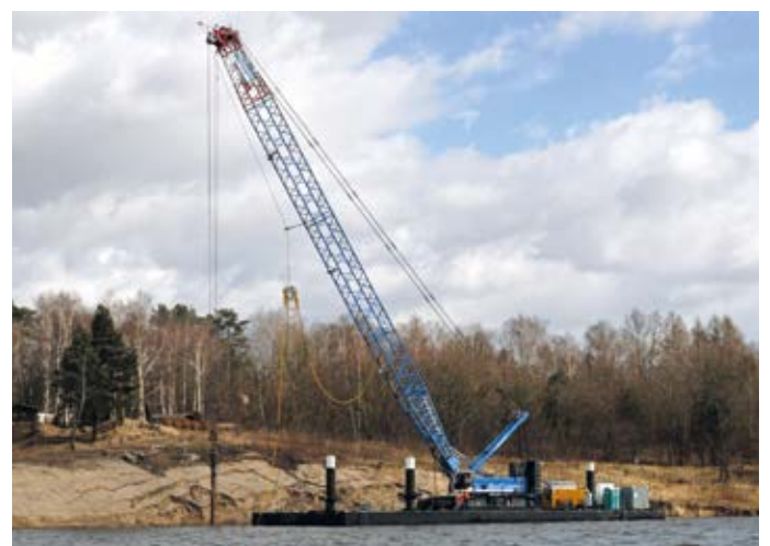
Seeseitige Rütteldruckverdichtung im Bereich S, 2015
