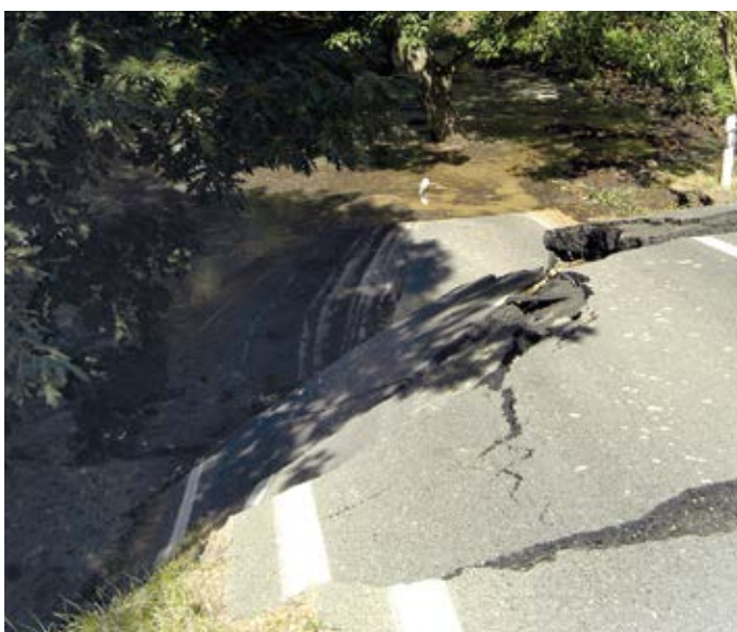
Verbindungsstraße Koblenz-Knappenrode, Auswirkungen eines Setzungsfließens, 2004
