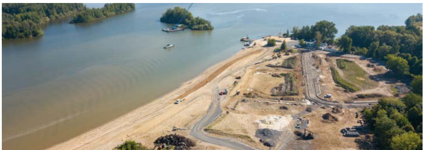
Baustelle des neuen Vereinszentrums am Knappensee, 2022
