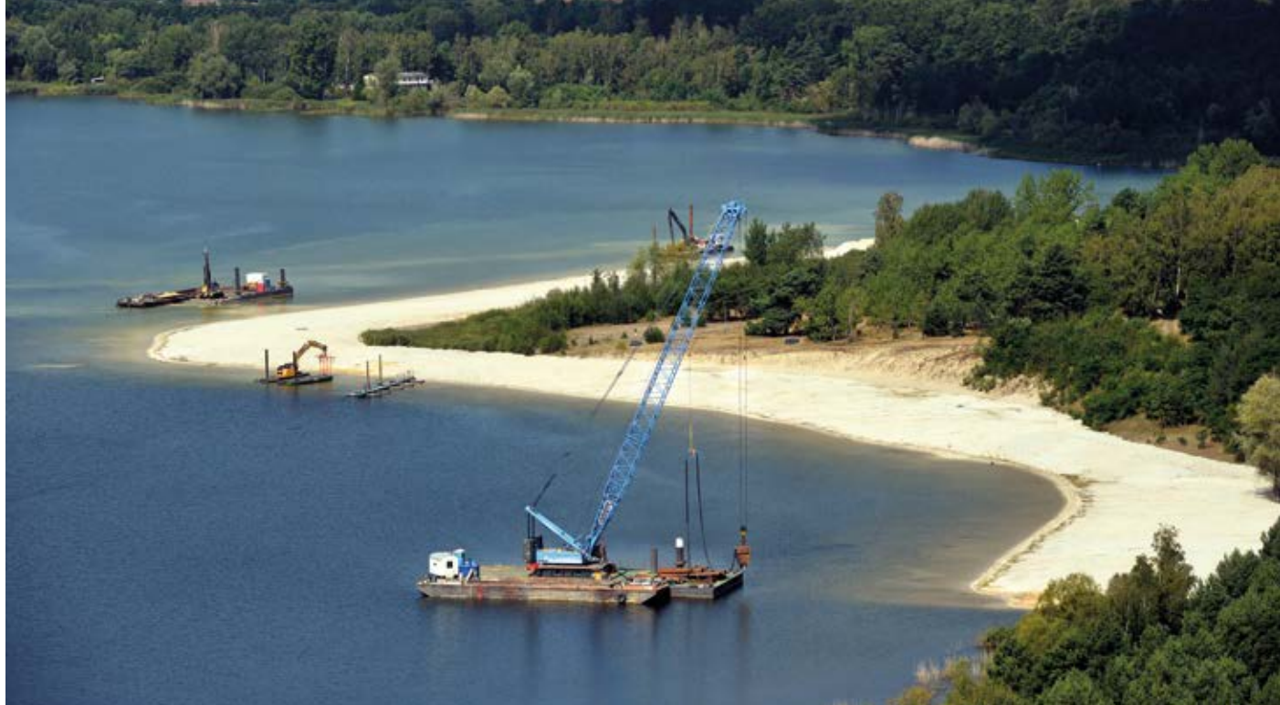
Sicherungsarbeiten in T und S-Nord, 2016
