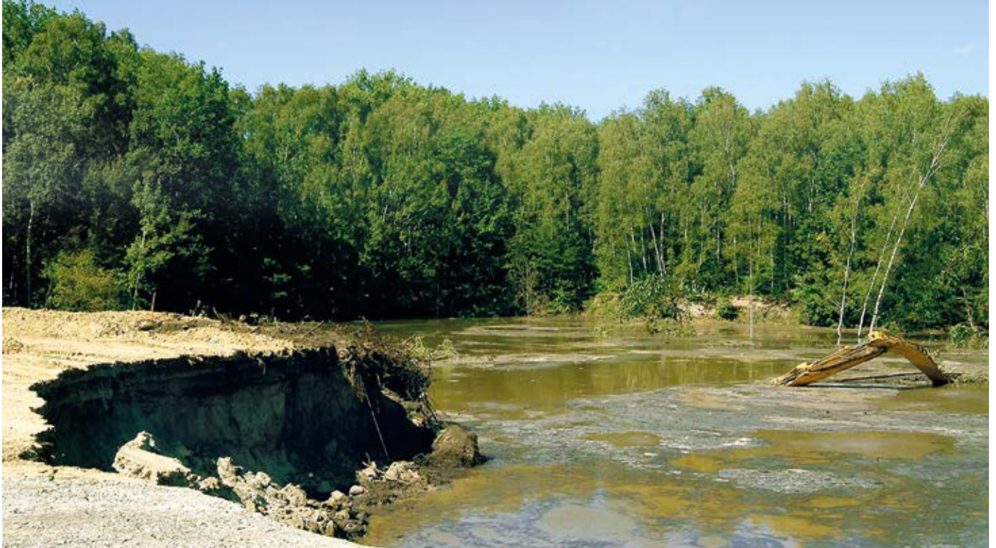
Setzungsfließen am Restloch 08/15, Koblenzer Straße, 2004
