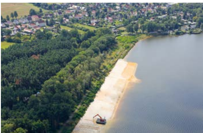
Leichte Rütteldruckverdichtung am Knappensee, D-Ost, 2021
