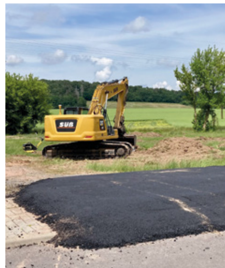
Die vorbereitenden Arbeiten zur Errichtung einer Entladestation für Tanklastwagen haben begonnen.
