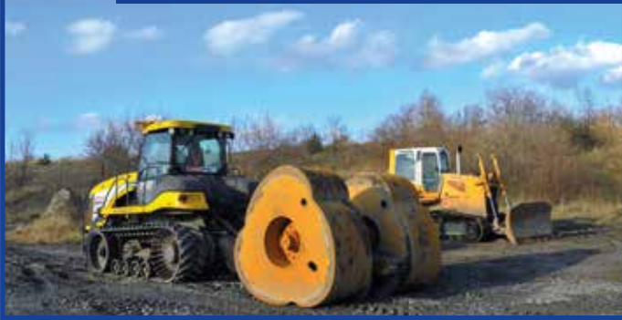
Befestigung des Geländes mit einer Polygonwalze
