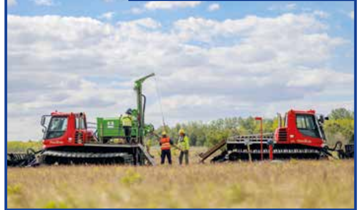
Vorbereitung der Sprengungen mit Hilfe zweier Pistenraupen
